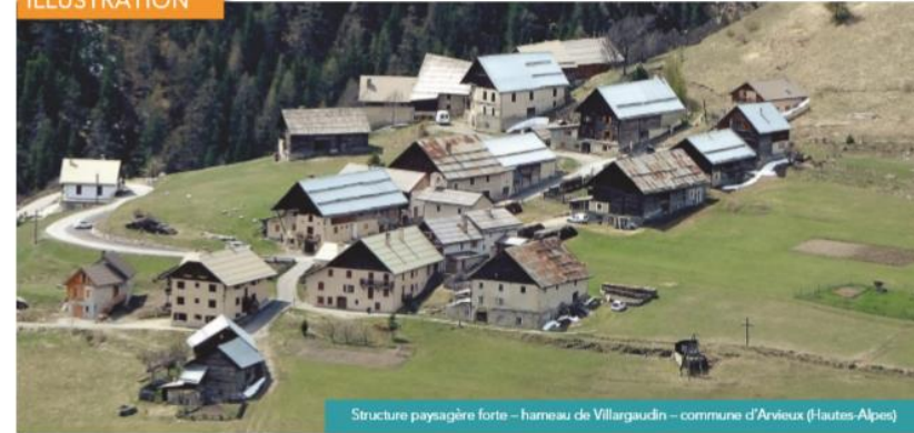
Structure paysagère forte – hameau de Villargaudin – commune d'Arvièux (Hautes-Alpes)
